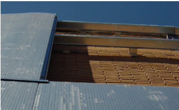
Fachada rehabilitada con paneles por el exterior
