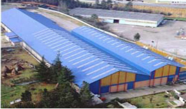
Cubierta y fachada de nave industrial
