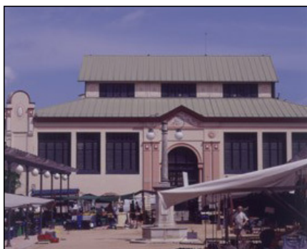
Rehabilitación de cubierta de un mercado
